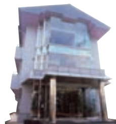
研修センター (静岡県駿河区)
